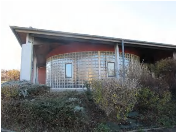
Photo avant travaux
