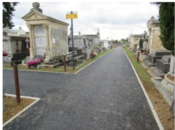
Photo après travaux
