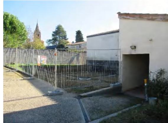
Début des travaux
