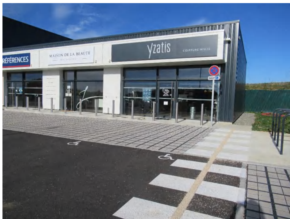
Parking PMR et cheminement le long de la façade desservant les 4 magasins
