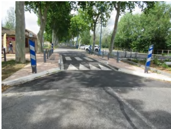
Photos après travaux
