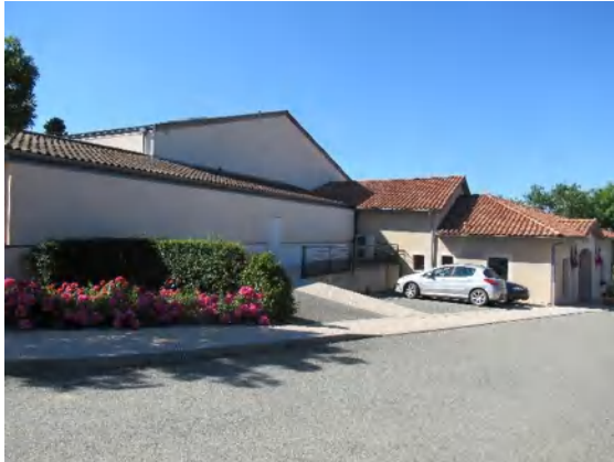
Photo avant travaux
