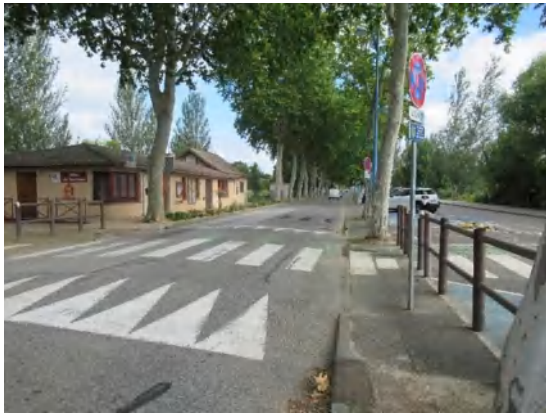
Photos avant travaux
