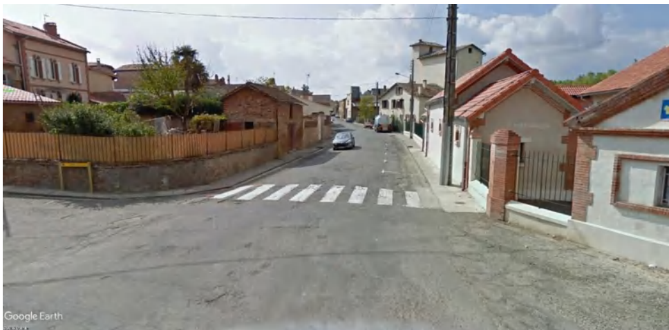
Photo avant travaux
