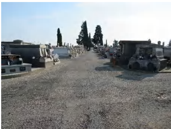
Photo avant travaux
