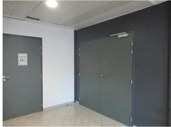
accès toilettes et salle de réunion
