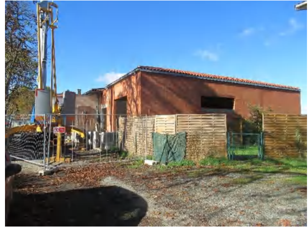
photo des travaux
