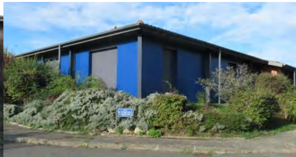
Photo après travaux
