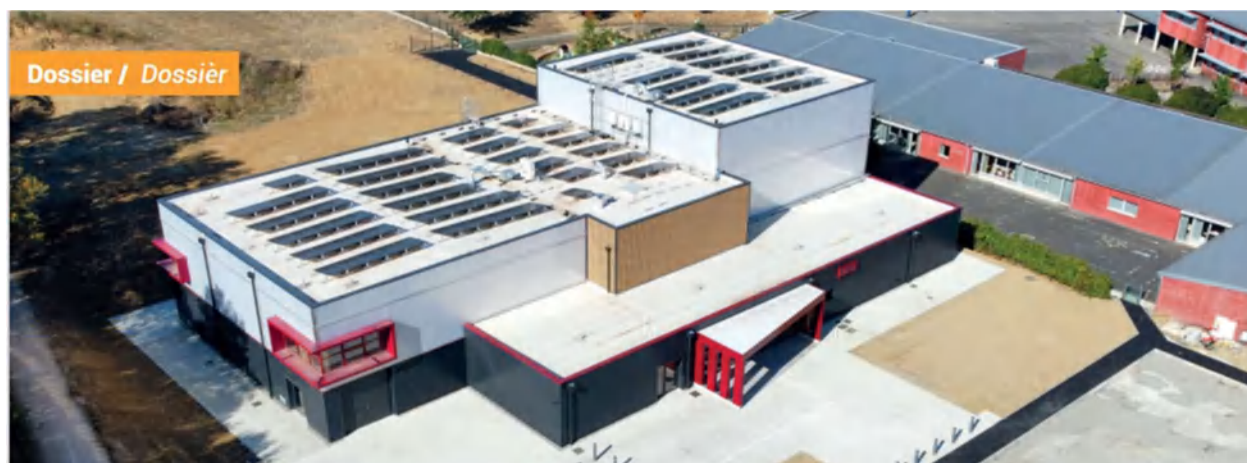
Photo du nouveau gymnase de L'Isle-Jourdain
