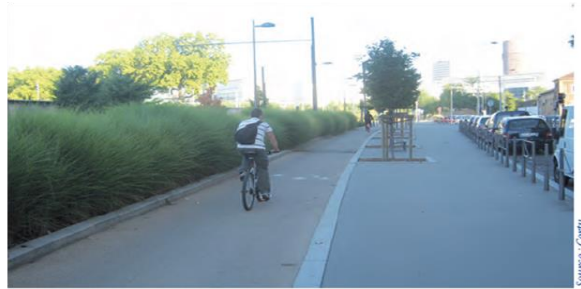
Piste éloignée de la chaussée
